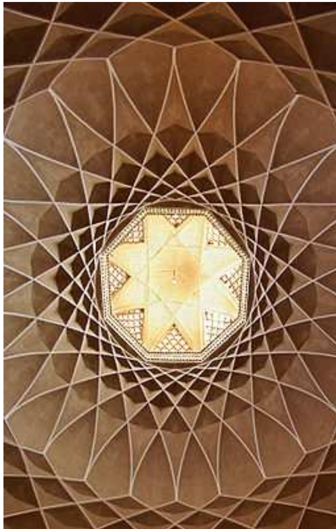
« Maison de Kasra », Yazd
